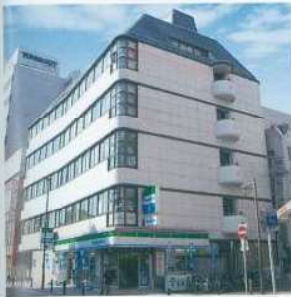
人、企業、商業施設が集まる天神にあるインキュベーション施設「ibb fukuokaビル」
